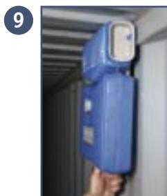
9 Mantenga la parte inferior de la varilla roscada y empuje la caja azul hasta el techo.
